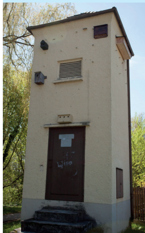
Das Trafohaus dient als neues Tierhotel.
